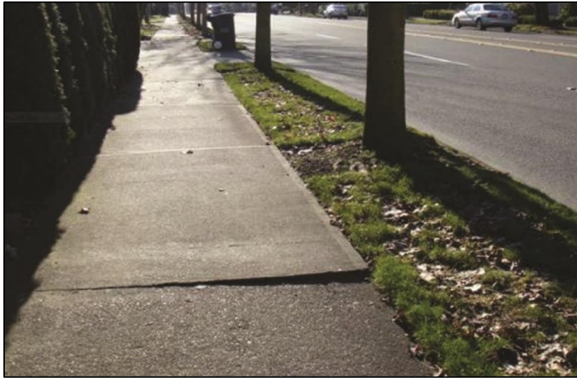
شکل ۱۰-۲- نمونه‌ای از عدم پیوستگی در روسازی پیاده‌رو
