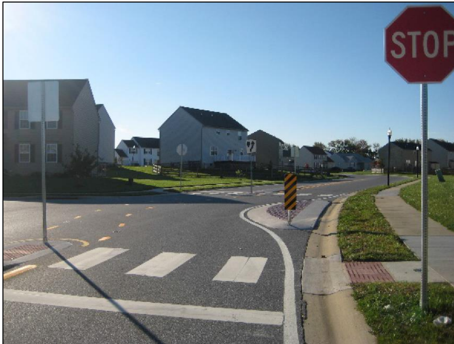
شکل ۴-۷- نمونه منحرف‌کننده جانبی در تقاطع سه‌راه
