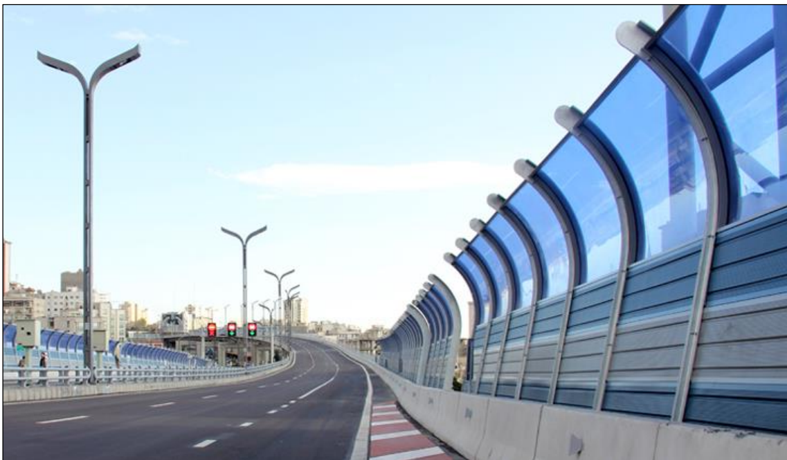
شکل ۱۵-۳- نمونه عایق‌های صوتی با جنس پریکسی گلاس
