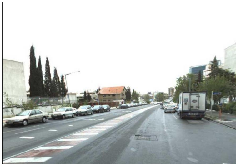
شکل ۴-۱۶- نمونه میانه بدون محدودیت فیزیکی و صرفاً با خط‌کشی
