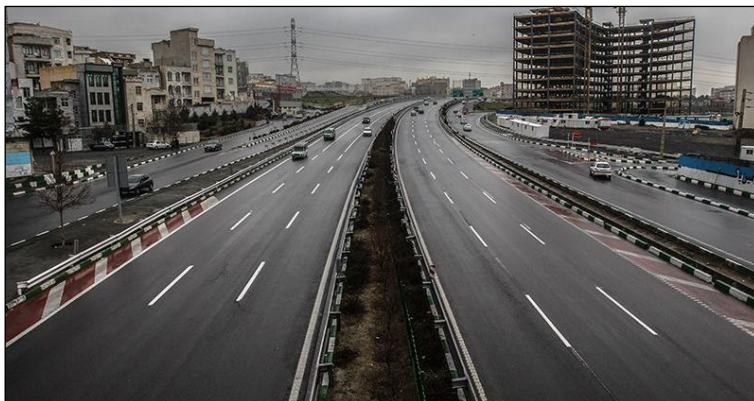
شکل ۴-۶- نمونه میانه با حفاظ طولی انعطاف‌پذیر
