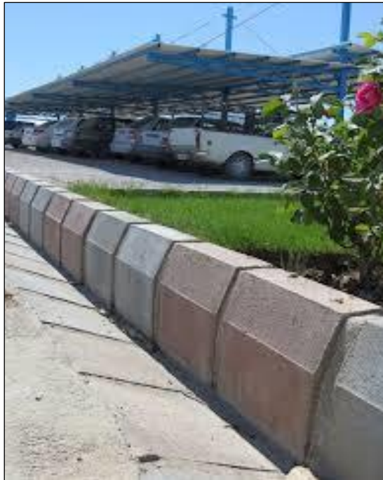
شکل ۴-۵- استفاده از جدول و آبروی مثلثی شکل برای جمع‌آوری آب‌های سطحی معابر
